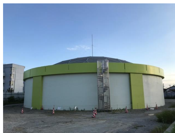
東海ポンプ場 6,900 m 3 配水池
