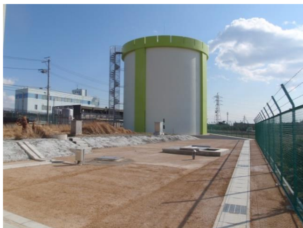
上野ポンプ場 2,000 m 3 配水池
