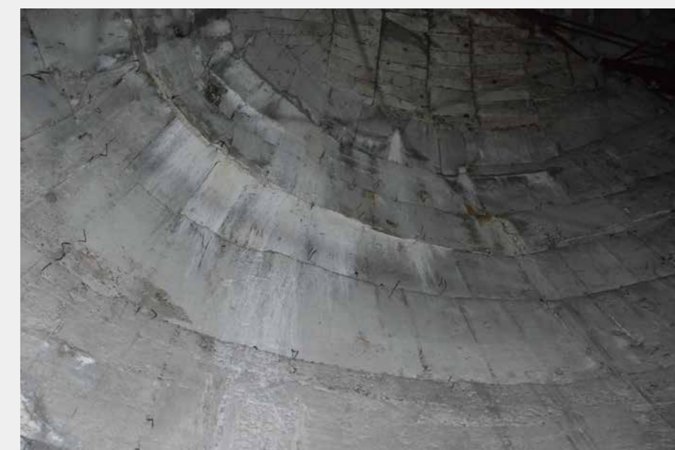
大仏内部に残る型枠の跡
