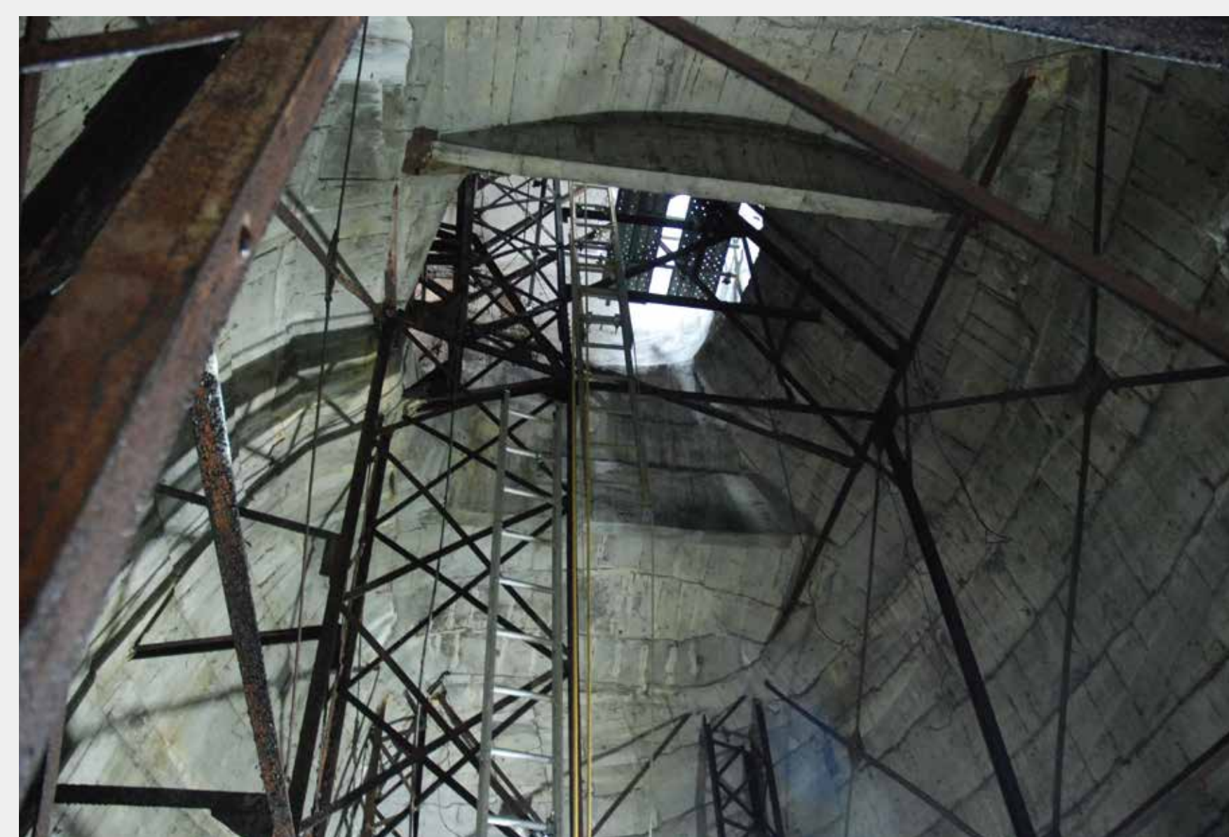
文化财产调查的情景 内部佛殿的天花板内侧为宽敞的空洞, 将脚手架一直搭到头部来对结构等进行了调查。
