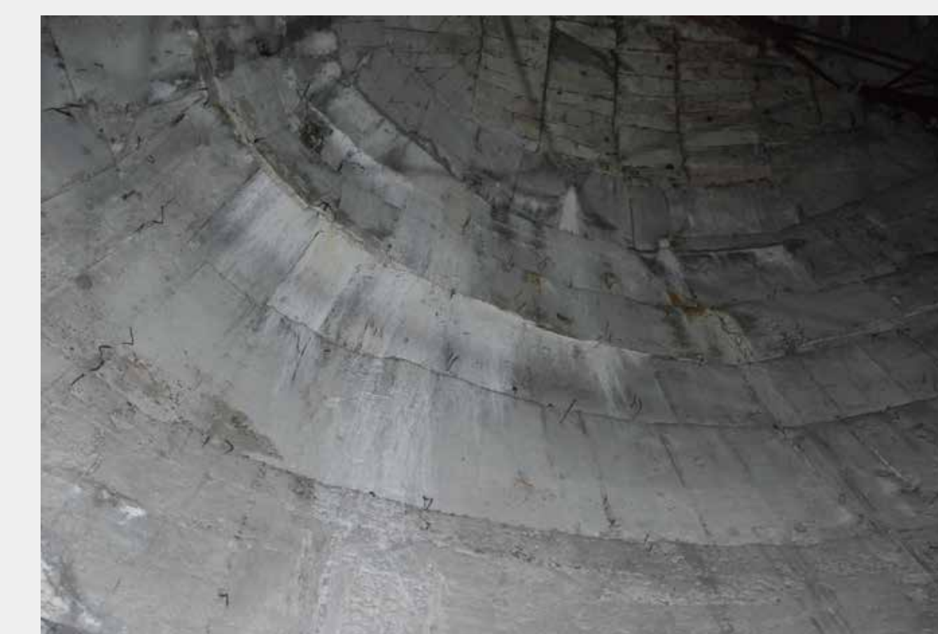
大佛内部残留的模具框架痕迹
