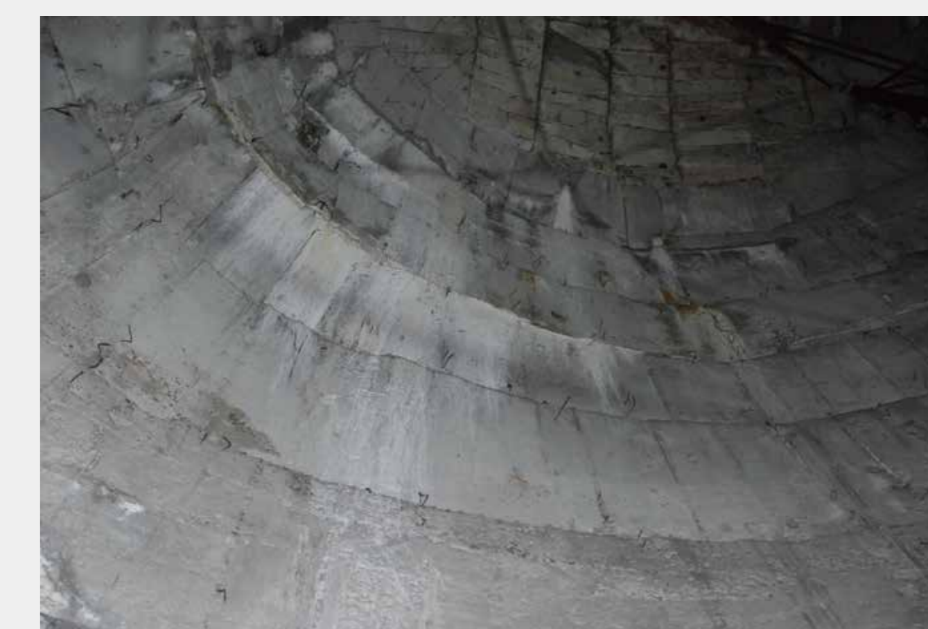
大佛內部殘留的模具框架痕跡
