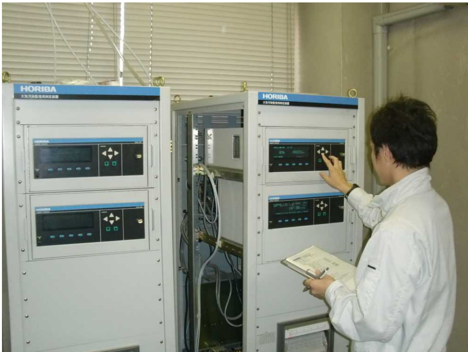
大気汚染自動測定器による常時監視：公害防止センター
