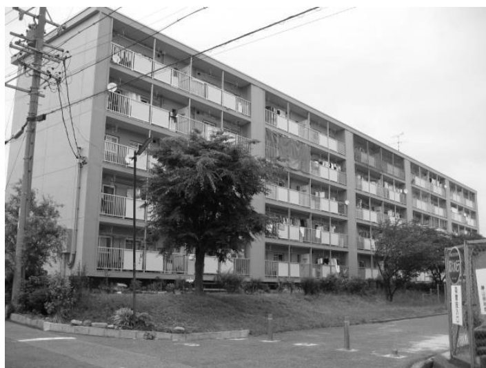
中層耐火5階建て（勝山）
