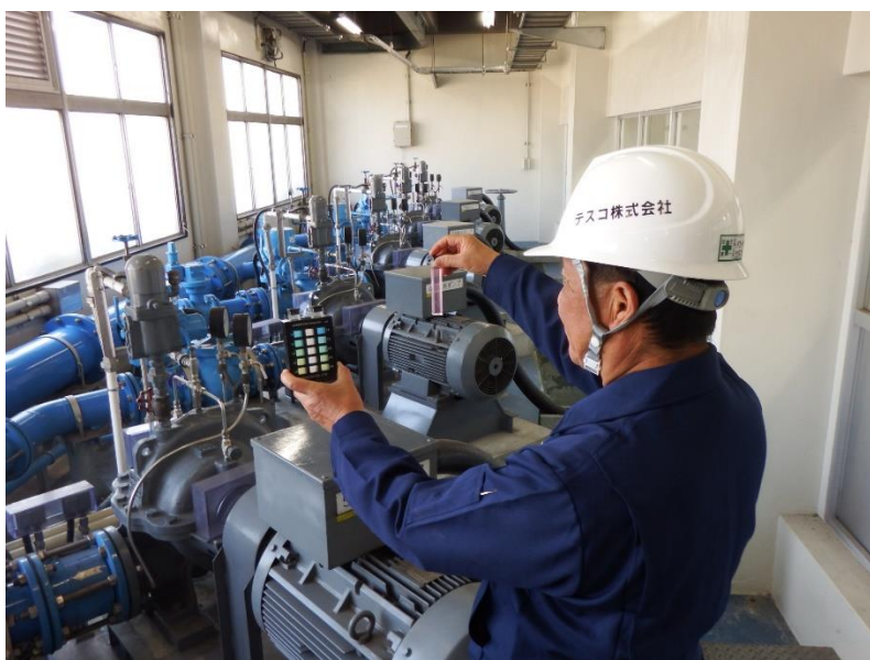
検査状況（上野ポンプ場）
