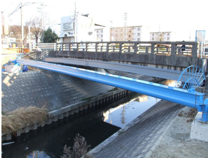
水管橋の整備
