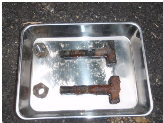
腐食したボルト
