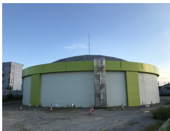
東海ポンプ場 6,900 m 3 配水池
