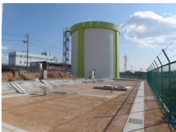
上野ポンプ場 2,000 m 3 配水池
