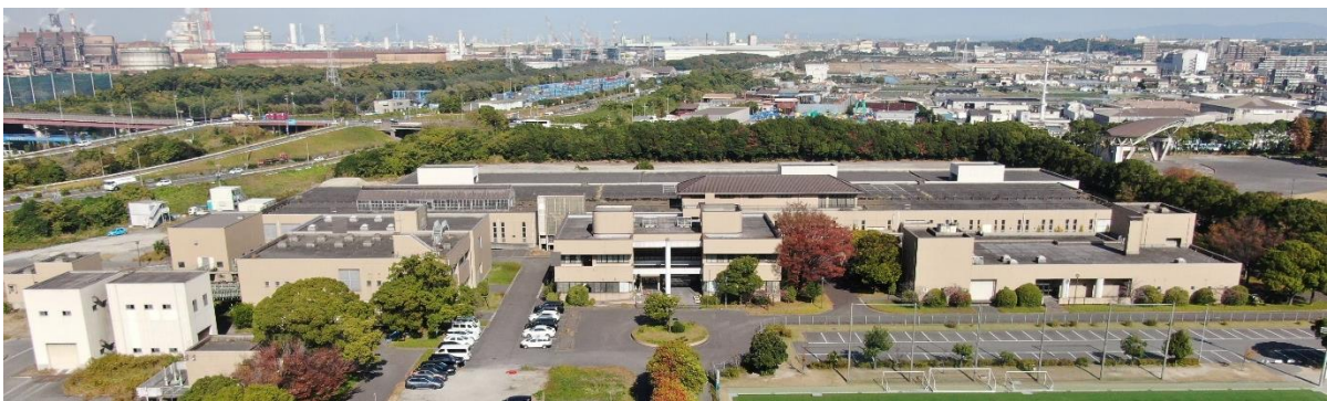
東海市浄化センター (所在地：東海市元浜町 63 番地の 2)
