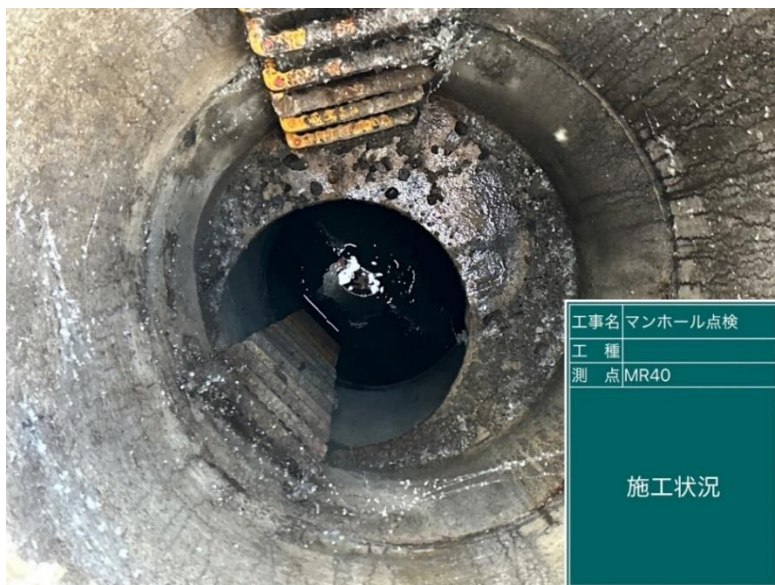
マンホール内部の状況
