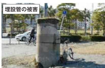
過去の地震では、液状化により電柱や下水道管などが被害を受け、停電や断水、また、トイレが使えなくなる、ガスが止まるなど、地震後の生活に大きな影響を及ぼしました。
