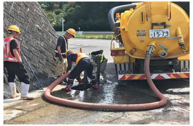
排水管清掃車による堆積土砂の吸い上げ作業
