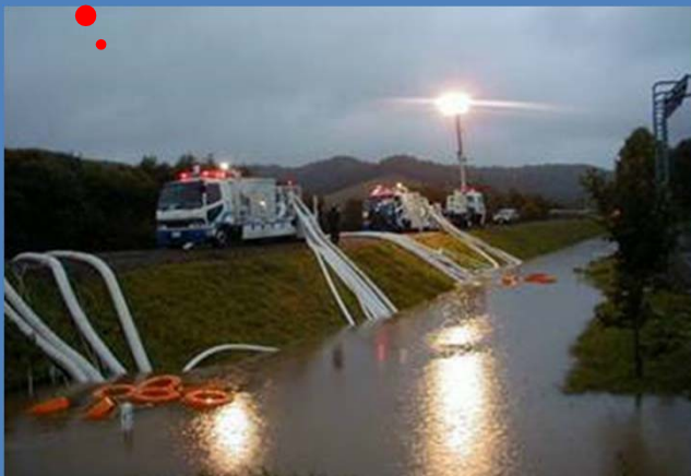
夜間排水作業を照らす照明車
