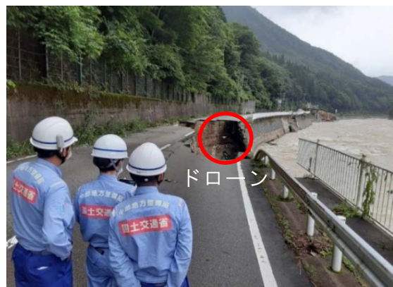
ドローンによる被災状況確認
