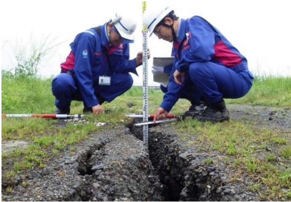
被災状況調査（道路調査班）
