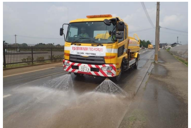
散水作業（応急対策班）
