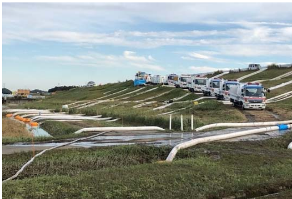
排水ポンプ車による排水作業
