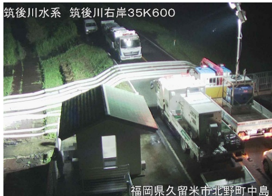
排水ポンプ車による夜間排水作業
