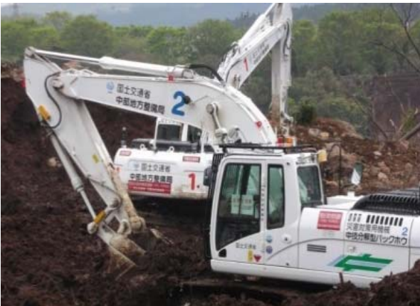
無人化施工バックホウによる道路啓開
