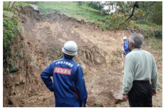
地元の方から被災状況の聞き取り調査
