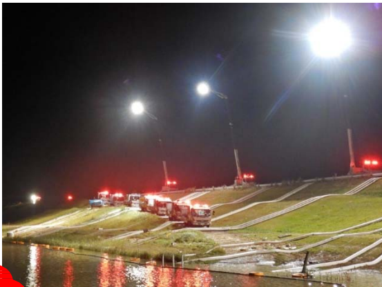
排水ポンプ車による排水作業
