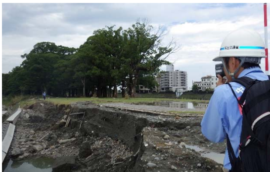
河川施設の被害状況の調査
