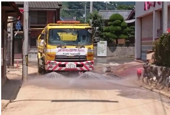
散水車による路面清掃作業
