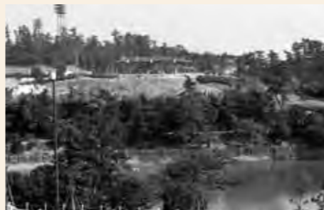
●大池公園完成 昭和48年8月
