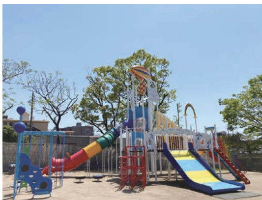
公園施設の長寿命化(遊具)
