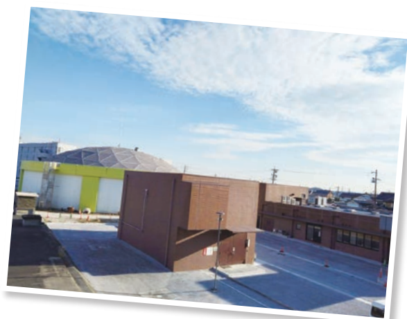
東海ポンプ場
