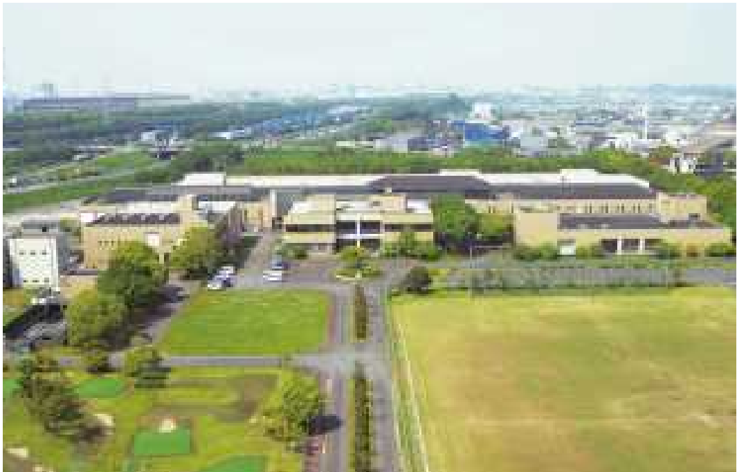
浄化センター
