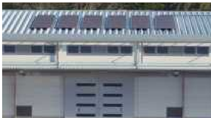
中央防災倉庫の太陽光パネル
