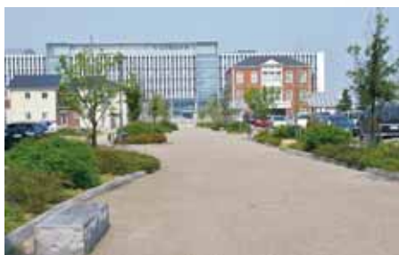
【太田川駅西歩道（15m歩道）】 駅から大田公園へつながる歩道です。
