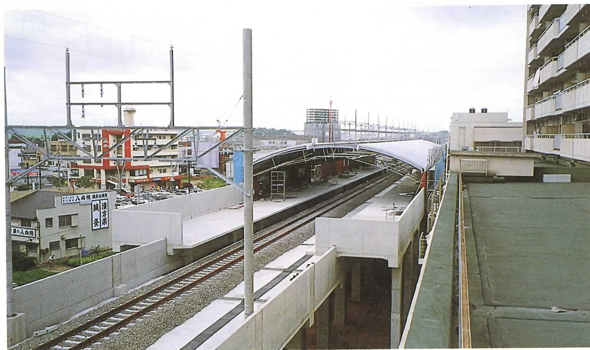
着々と進む名鉄常滑線連続立体交差事業(尾張横須賀駅)
