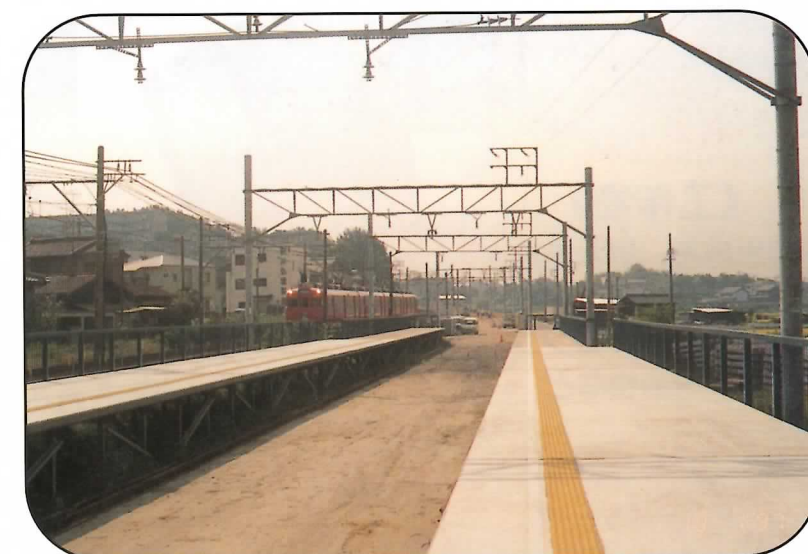
◎仮線高横須賀駅ホームから中ノ池方面を望む
