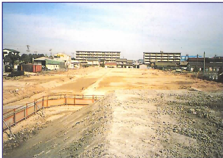
◇造成工事(天尾崎付近)
