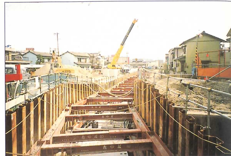
◇ 幹線排水路工事 (呉天石付近)
