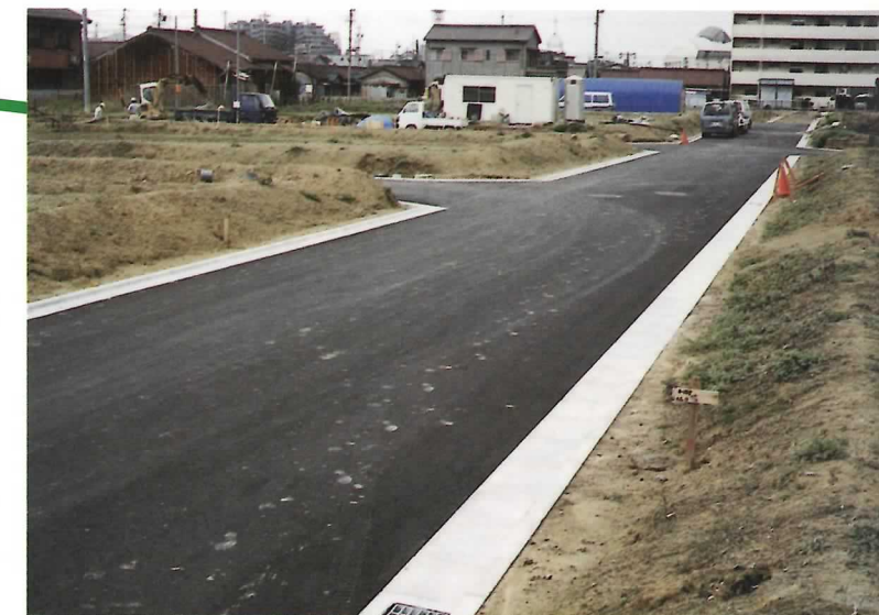
◇区画道路築造 (天尾崎付近・平成12年3月)
