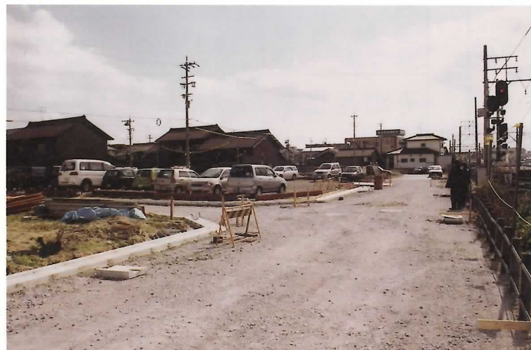
(道排水路築造工事)
