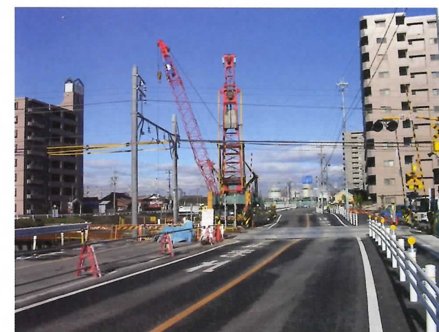
東海緑線・仮橋りょう工事
