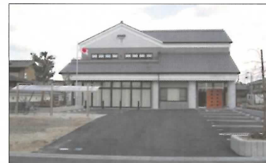
■ 移転先状況（大田町公民館）
