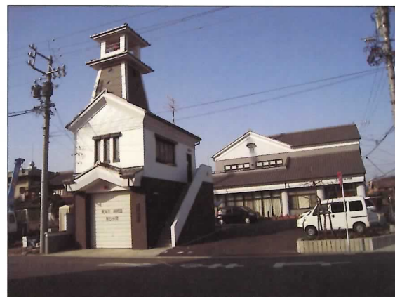
移転先状況（消防団第5分団詰所）
