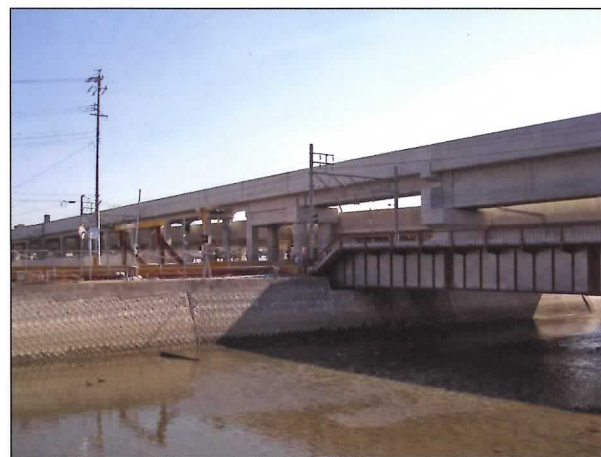
大田川橋りょう付近
