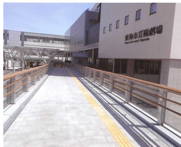
太田川駅西歩道橋
