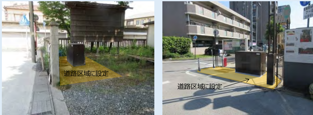
図 53 電力地上機器部設置状況
