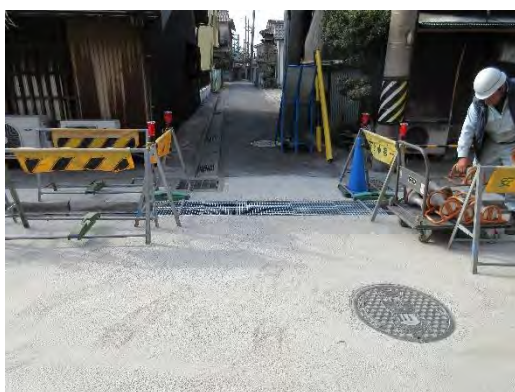
図 67 仮蓋取付図及び仮蓋設置状況
