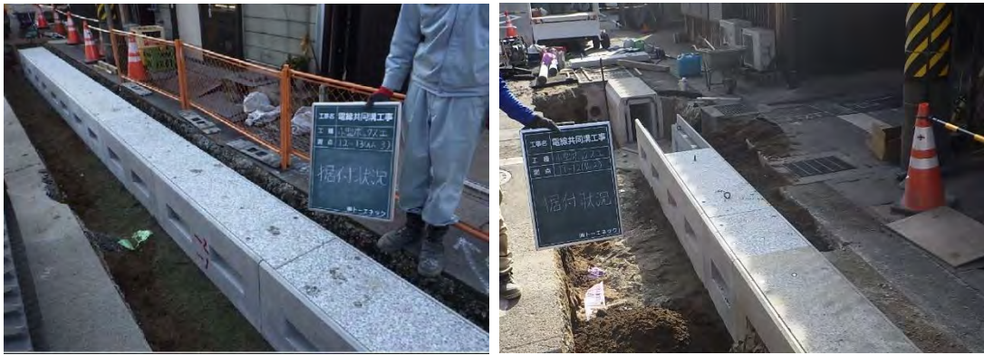
図 57 小型ボックス据え付け状況
