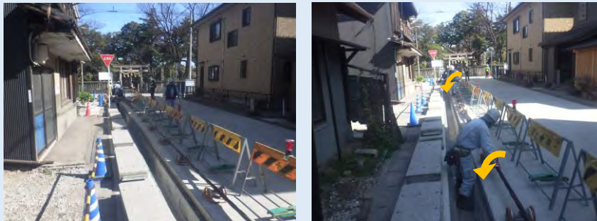
図 70 電力ケーブルの布設状況
