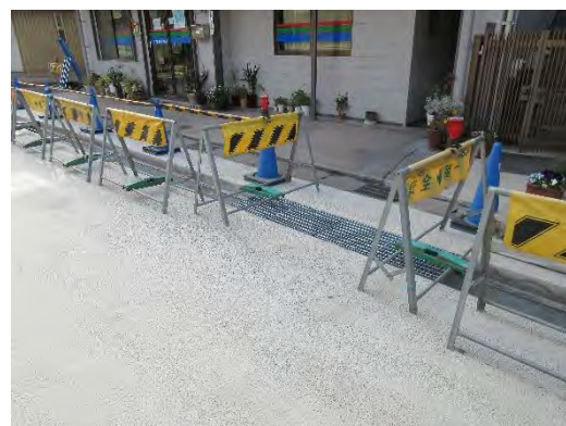
図 67 仮蓋取付図及び仮蓋設置状況
