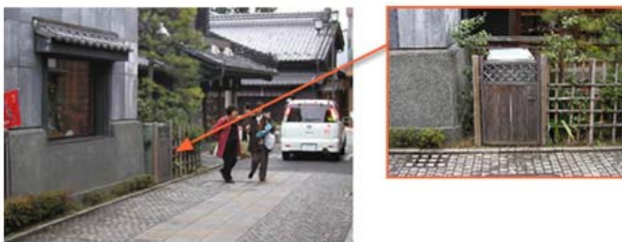
図－１３ 地上機器を民有地に設置した事例（出典：国土交通省ＨＰ）
