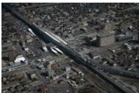
事業完了した鉄道の連続立体交差事業(H23)
