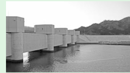
▲鶴住居・片岸地区 防潮堤・水門
