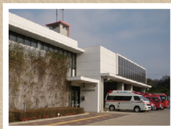
▲地域防災センター
