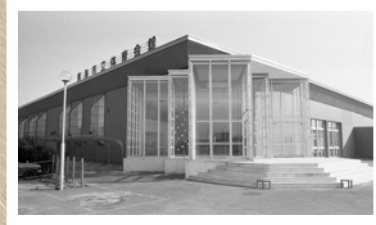
ボウリング場を 再利用して建て られた体育会館 (昭和53年)
