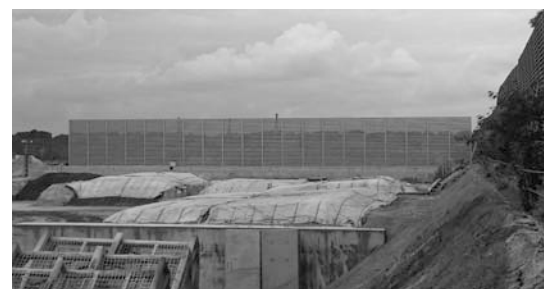
▲大同特殊鋼(株)知多工場 ② スラグ処理場内 防じんフェンス設置 (60 m)
