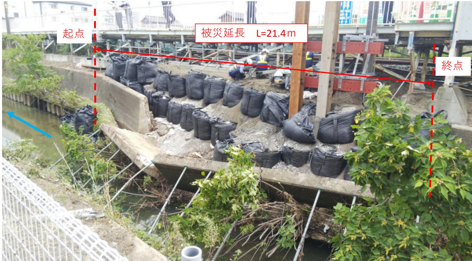
背面水圧の影響により、コンクリート擁壁が擁壁継ぎ目を境に崩壊した。
