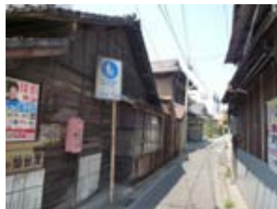
住宅地に据えられた消火器
