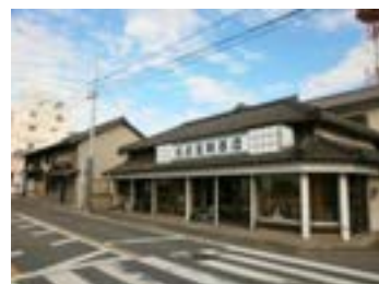
一階店舗部分を改築
