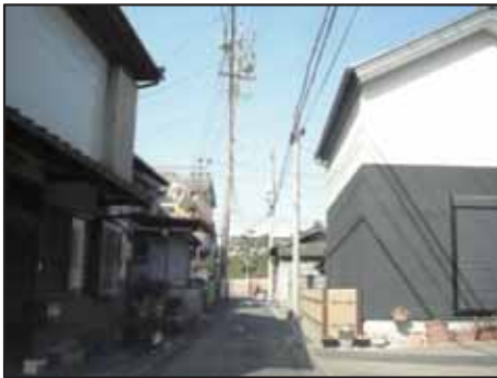
図：狭あい道路（東海市内）
