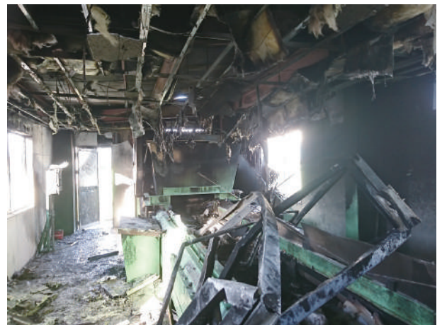
リチウムイオン電池の発火が原因で焼けてしまったリサイクル工場 (提供元：公益財団法人日本容器包装リサイクル協会)
