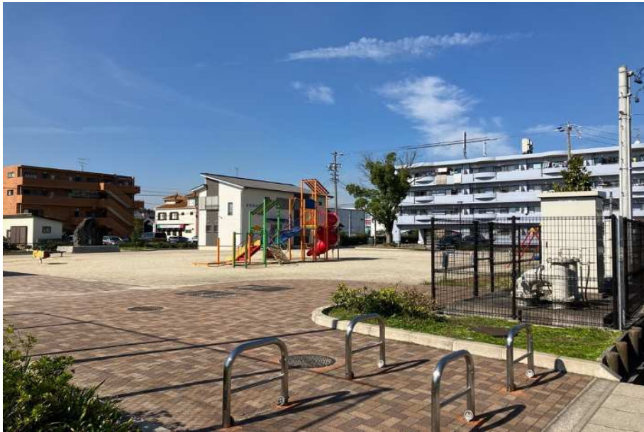
姫島公園 (地下貯留施設)
