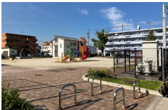
姫島公園（地下貯留施設）
