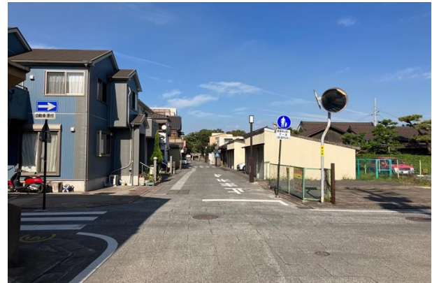
横須賀地区無電柱化
