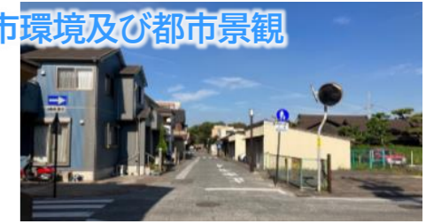
横須賀地区無電柱化
