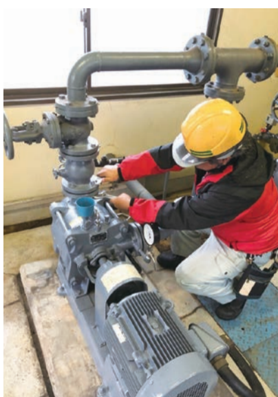
用水機場の運転作業(浜新田)
