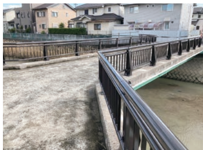
橋梁維持工事(西番水橋)
