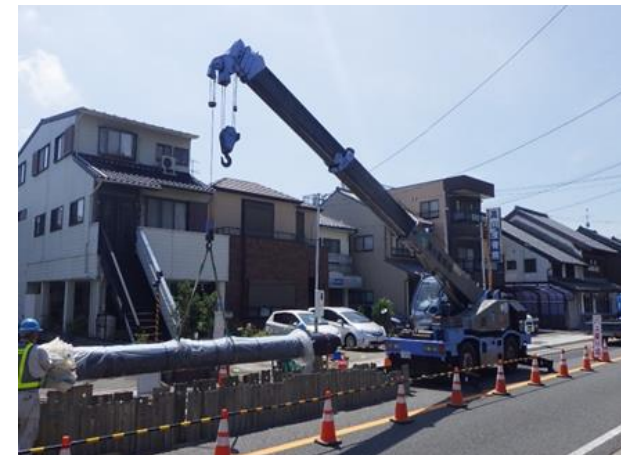
水道管の更新工事
