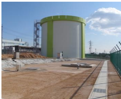
配水池 上野ポンプ場
