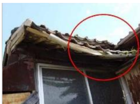
ロ：軒の裏板、垂木等が腐朽し、軒が垂れ下がっている例（25 点）
