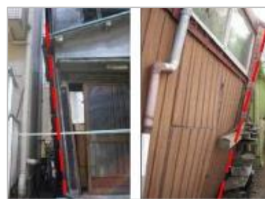
ハ：柱の変形が著しく崩壊の危険がある例
