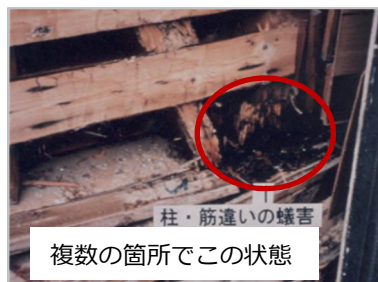
ロ：柱、筋かい端部等の複数箇所で蟻害・腐食・破損等がみられる例
