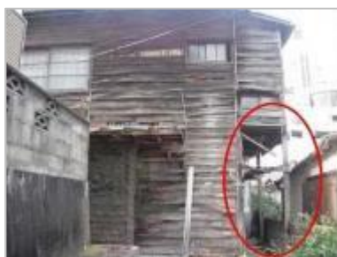
ロ：柱の数箇所に破損があり傾斜している例
