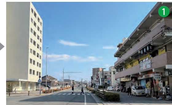
整備後(太田川駅北線)
