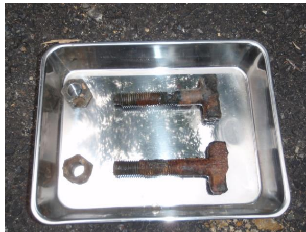
管を繋ぐボルトの腐食
