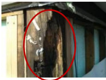
イ：局部的に柱で破損がみられる例
