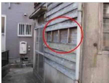
イ：外壁の仕上げ材の一部がはがれ、下地が露出している例（15点）
