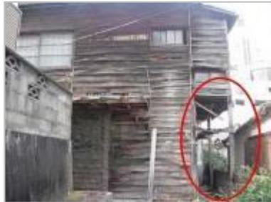
ロ：柱の数箇所に破損があり傾斜している例
