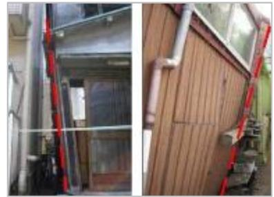
ハ：柱の変形が著しく崩壊の危険がある例
