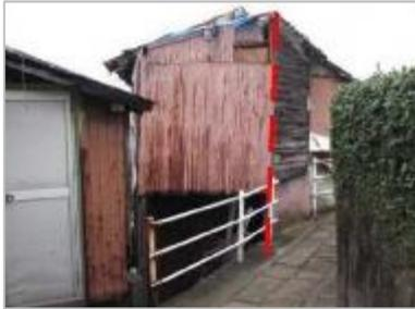
イ：一部の柱が傾斜している例
