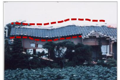
ハ：建築物全体の変形が著しく、軒先の線・棟の線が歪んでいる例
