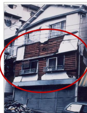
ロ：外壁が剥落し、著しく下地が露出している例（25点）
