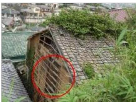
ロ：外壁が剥落し、著しく下地が露出し、壁体を貫通する穴を生じている例（25点）
