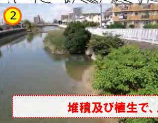
3 堆積及び植生で、川の流が阻害される
