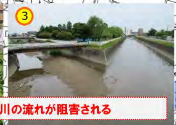
2 堆積及び植生で、川の流が阻害される
