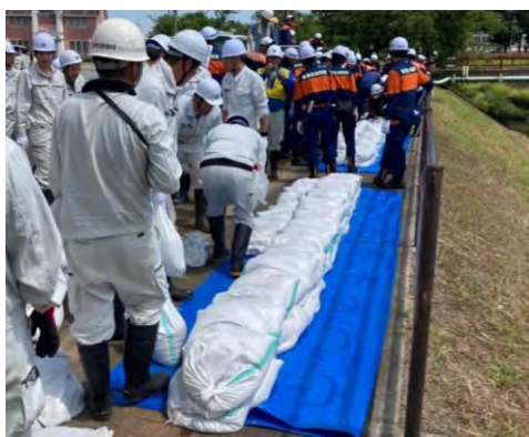
昨年の改良積み土のう工法の様子
