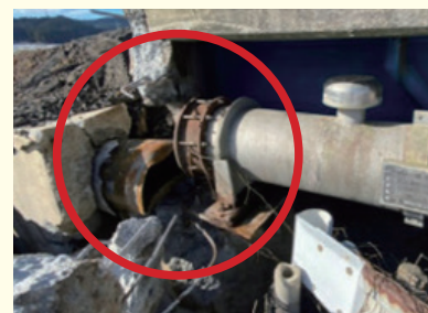
▲能登半島地震の影響により破損した水道管
