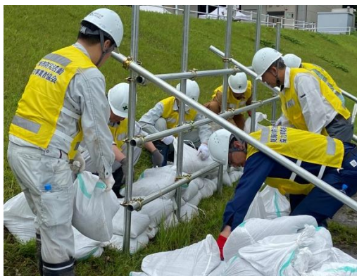
昨年の杭打ち積み土のう工法の様子
